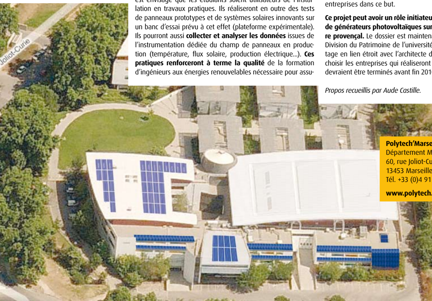
Projet photovoltaïque à Polytech' Marseille.
